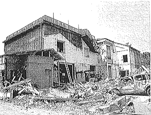
津波に耐えた社屋。壁にはかつての木造部分の屋根の跡が白く残る
